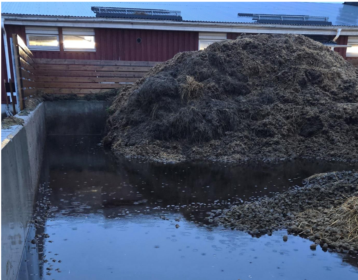
Figur 5. Foto på LRK:s gödselplatta vid ridhuset. Gödselplattan har gjuten botten och gjutna kanter på tre av fyra sidor.
