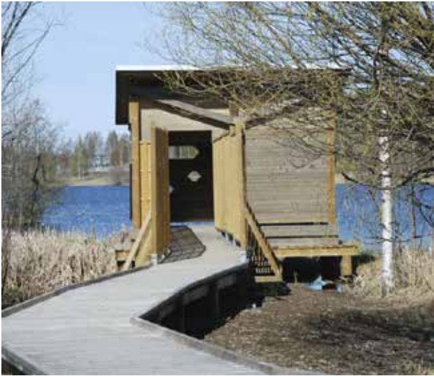
Gömsle vid Mjökuddstjärn
