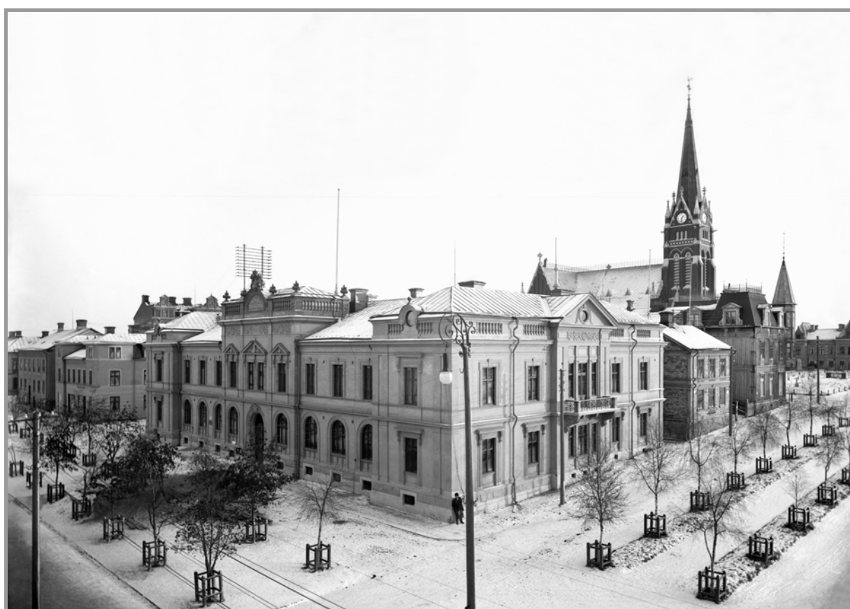
Riksbankshuset med Riksbankens avdelningskontor, postkontor, telegraf och telefonstation samt bostadslägenheter. Till vänster Storgatan – till höger Kyrkogatan.
