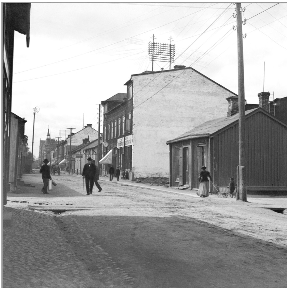
Storgatan mot residenset. Ebeneserkyrkan uppfördes sedermera där det lilla trähuset på höger sida är beläget. Foto: Landskanslist J. G. Lindgren, omkring 1900. Luleå kommuns stadsarkiv.
